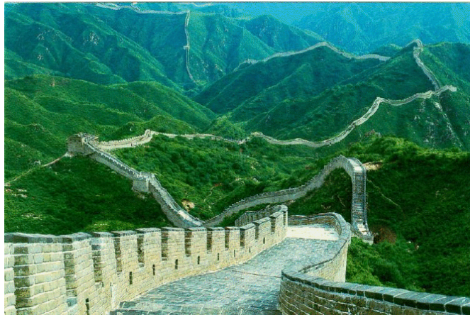
Figura 34: Muralha da China
